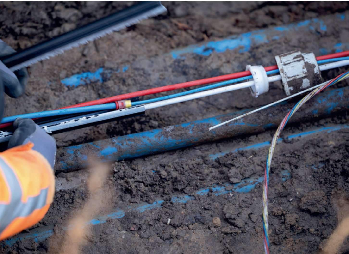
Werkzaamheden aan het gesloten NAFIN-glasvezelnetwerk, de eerste PPS van Defensie, in samenwerking met KPN
