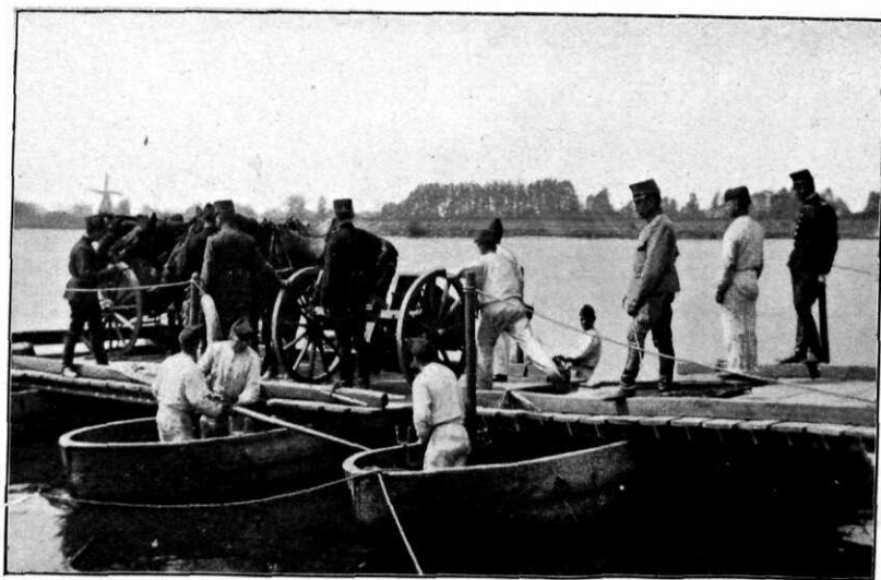
Het overzetten van één stuk op een ponton-vlot over den IJssel bij Olst.
