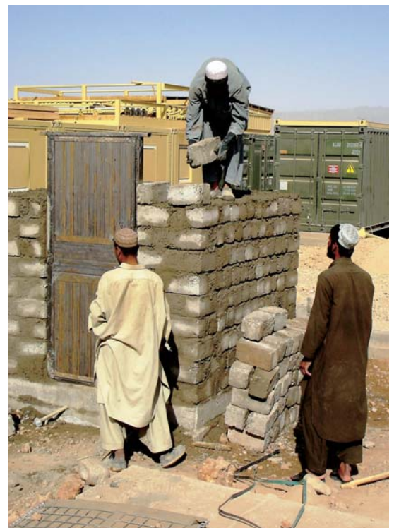
De bouw van een PRT-huis (Foto AVDD, F. van Biemen)
