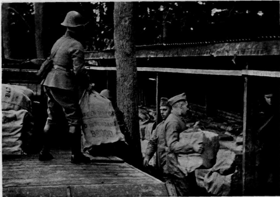
Afladen van het Aut. Bat. op de Aanvullingsplaats.
