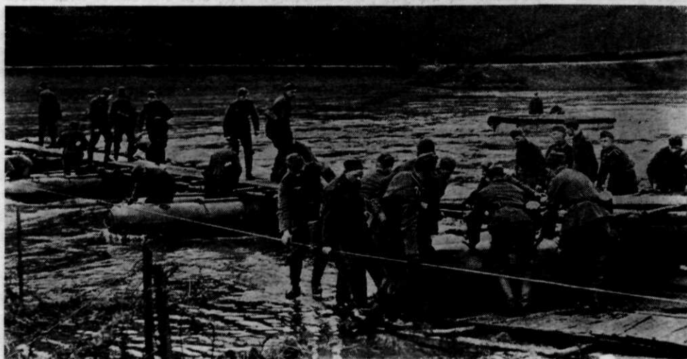
Duitse pioniers, bezig met het maken van een loopbrug met behulp van kleine drijfzakken.
