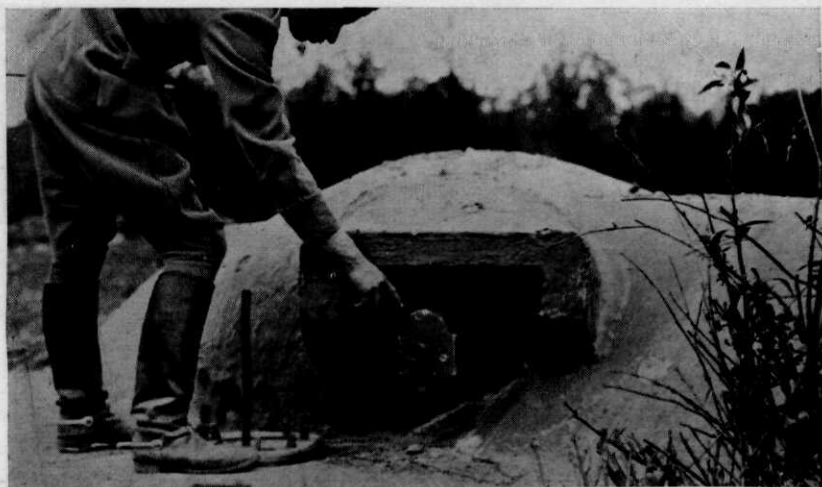
Afb. 1. Stalen kazemat No. 19 voor zwaren mitrailleur, voorzijde. Heeft ontvangen 49 treffers, waarvan 9 op het schietgat, de boldoorvoering en den stalen mitrailleurmantel. Driemaal is de loop verwisseld (1 treffer in den loop ontvangen en 1 patroon gescheurd in den loop).
