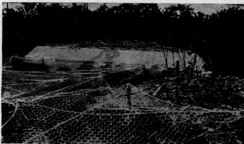
Afb. 4. Dezelfde kazemat No. 13 aan de achterzijde, met het maskeeringsnet. Het groot aantal treffers in den rug ontvangen, is duidelijk zichtbaar, vooral in het midden.
