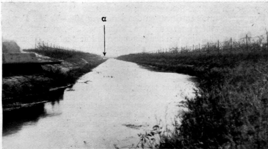
Het defensiekanaal met de beide draadhindernissen. Foto genomen bij kazemat 546 (zie geheel links) in Noordelijke richting. a = kazemat 547
