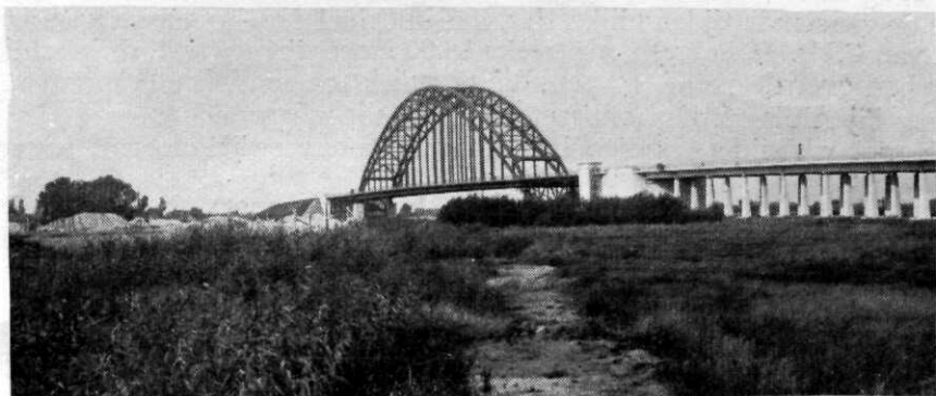
Afb. 1. Brug over de Noord bij Alblasserdam.
