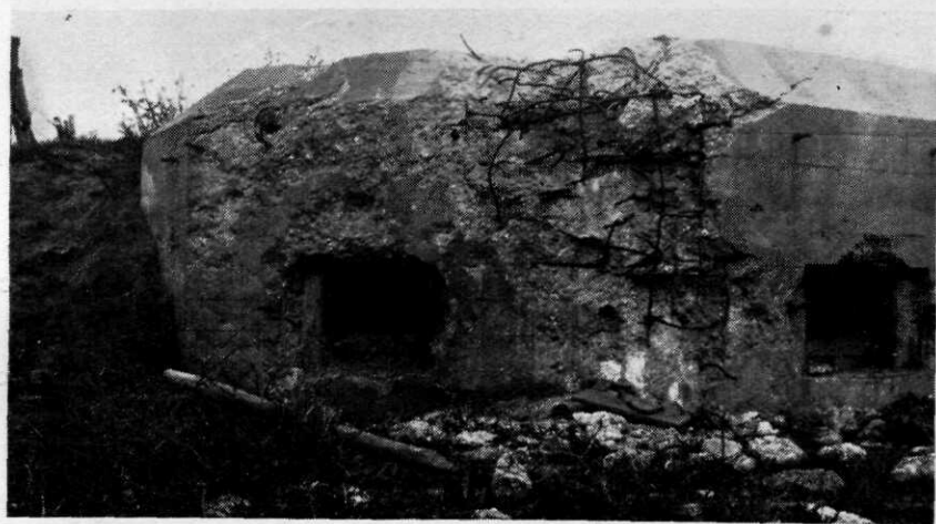
Afb. 9. Voorwand en Zuidelijke wand van kazemat 56 S.
