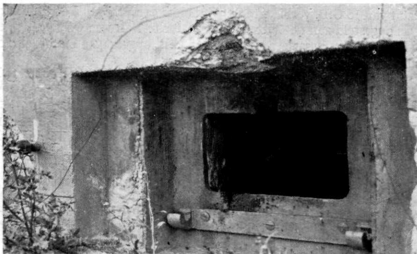
Afb. 6. Zuidelijke wand van kazemat 59 S.
