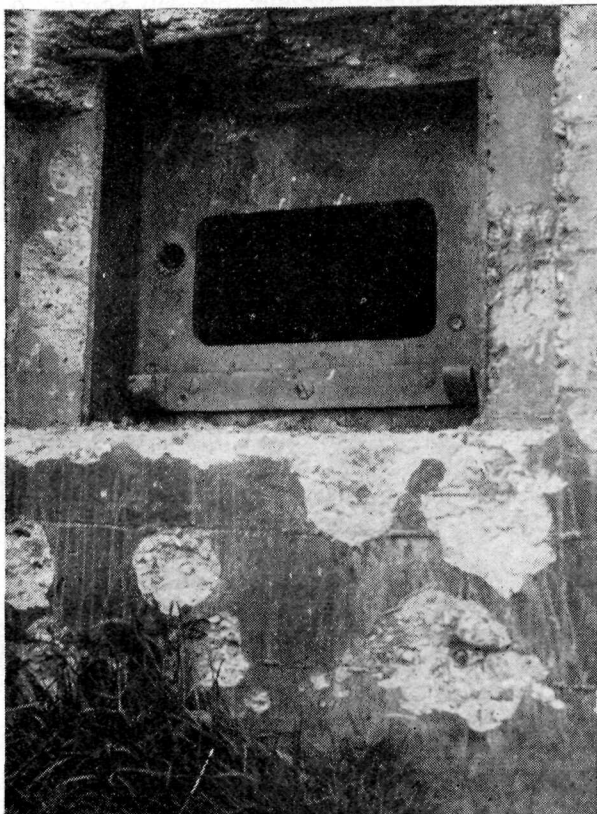
Afb. 12. Kazemat 110 S. Schietgatraam met voltreffer van pag.
