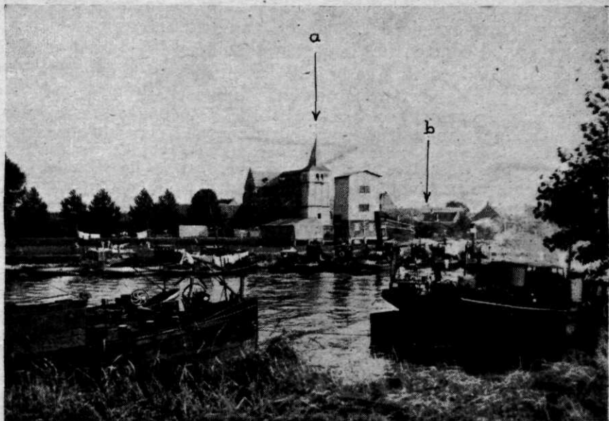
Afb. 5. Foto, genomen van kazemat B 5 in de richting Maasbracht. a. = Kerk te Maasbracht; b = Opstellingsplaats Duitsch geschut.
