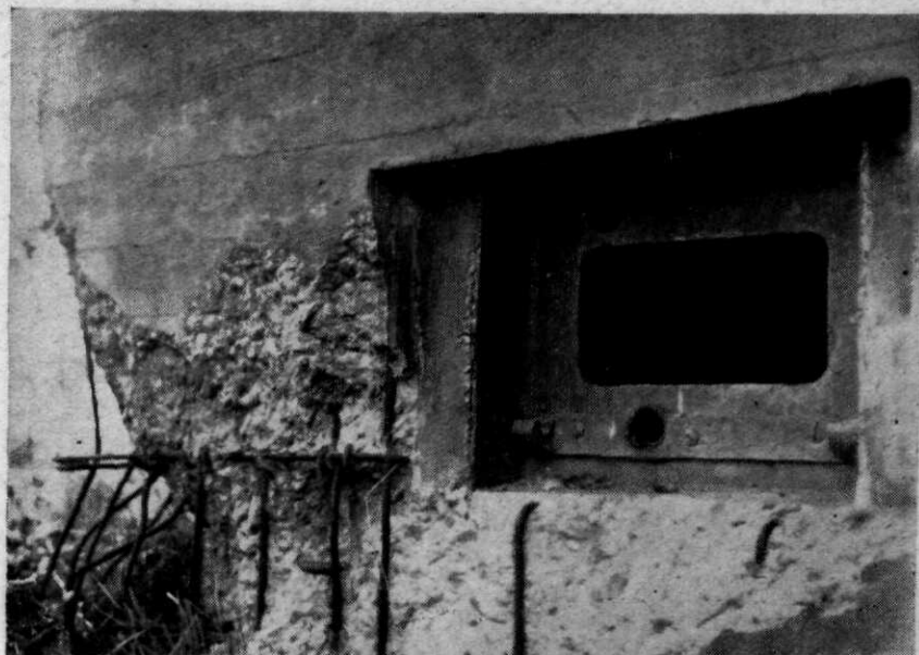
Afb. 9. Kazemat S 6. Voorwand met treffer door het schietgatraam.
