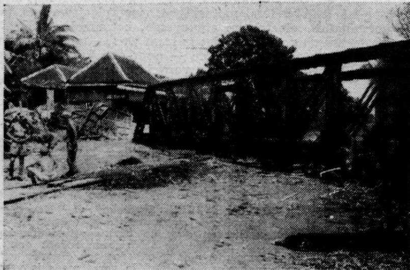
Afb. 1 Deze spoorbrug diende als versperring op de weg Semarang—Demak en werd tijdens de actie onttrokken en na de actie door de 6 genieveldcie op zijn plaats teruggerold
