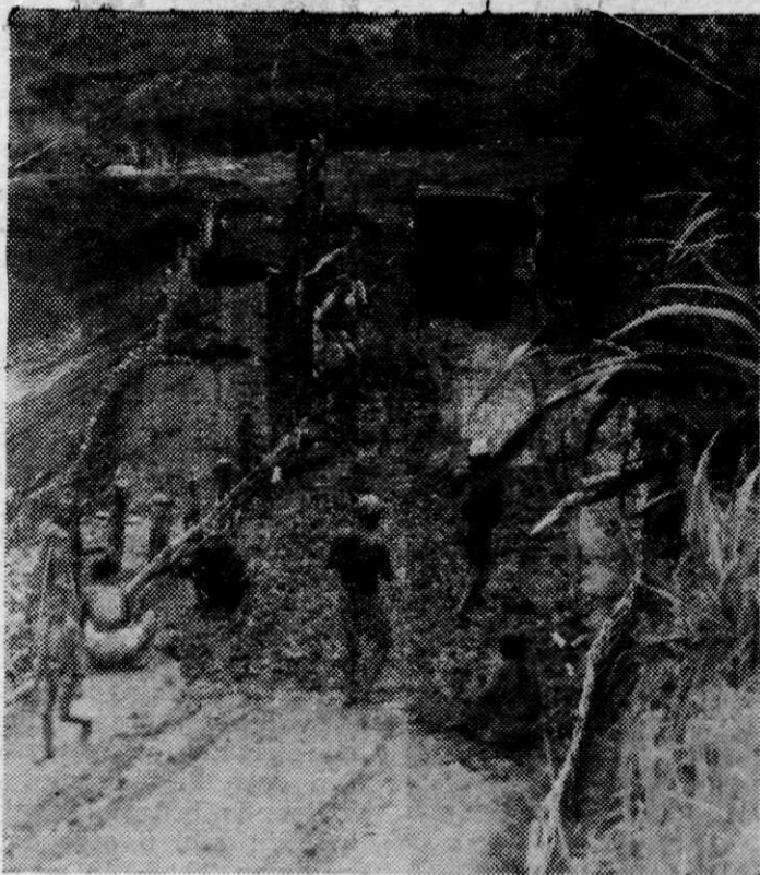
Afb. 2 Een bergweg W. van Soemowono (Z.W. van Semarang) werd geheel afgegraven aangetroffen en door hulpvaardige Indonesiërs laagsgewijze aangevuld onder leiding van de 5 genieveldcie.
