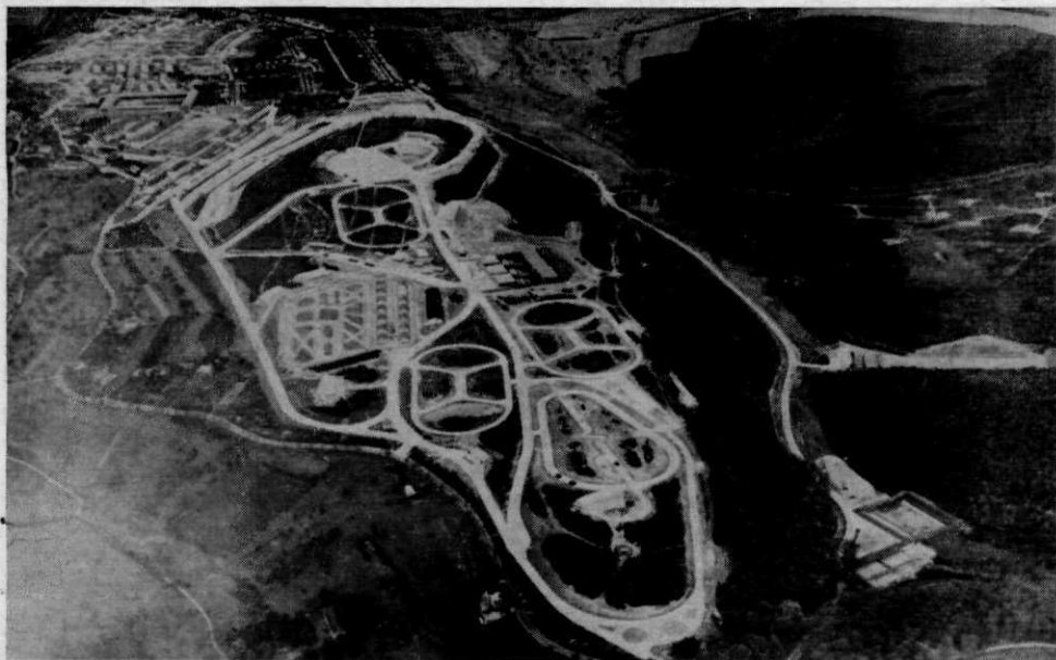
Tankrijbanenproject te Trier
