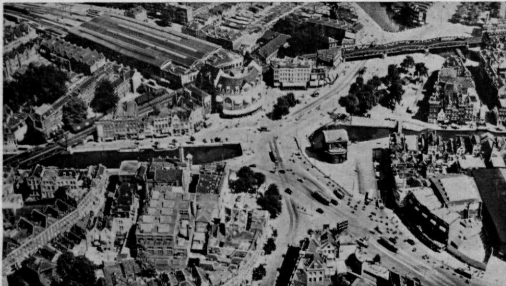
Het Hofplein te Rotterdam en omgeving vóór het bombardement.
