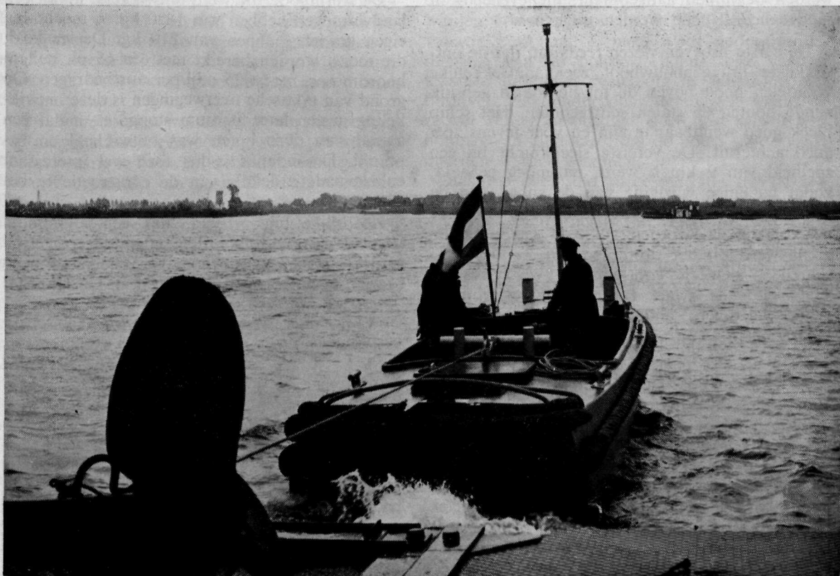
Sleepproeven met een caisson
