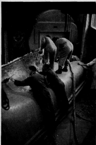
Overzicht van de werkzaamheden tijdens de vervaardiging van de mal voor de bruggebouwboot
