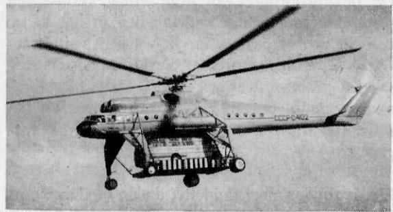
Een Russische „Vliegende kraan” met een hefvermogen van 15 t (militaire versie: Mi-10 „Harke”)
