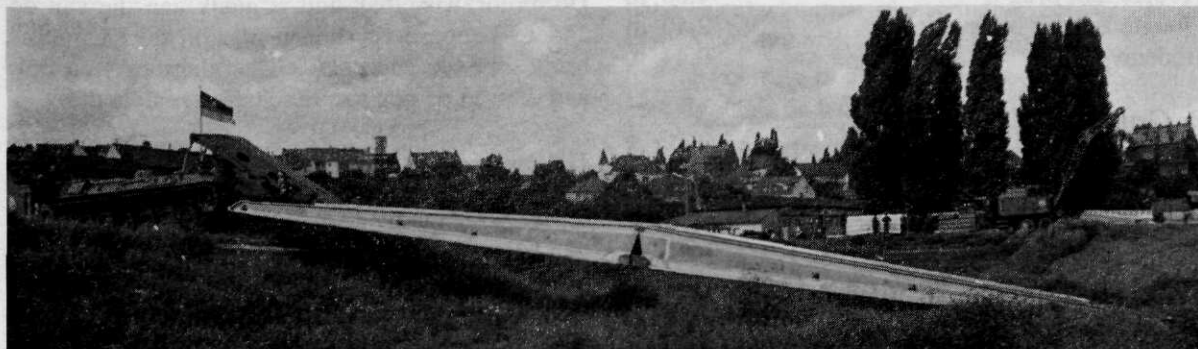
Afb. 10 Het neerleggen van de brug
