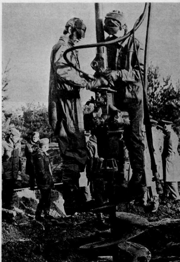
Afb. 5 Aansluiten van de hydraulische leidingen van de grondboor
