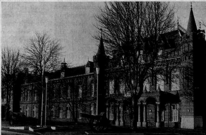
Afb. 1 Stafgebouw AOC, Chassé-kazerne Breda
