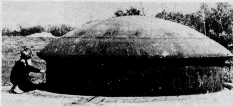
Afb. 5 De stalen koepel met twee 120 mm kanonnen
