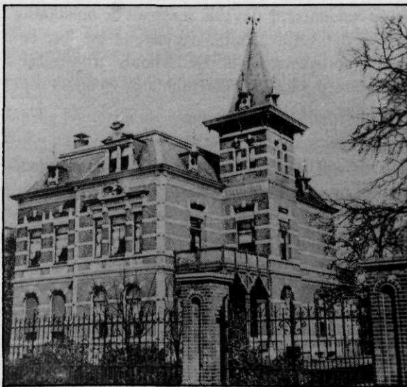
Afb. 1 De villa Mathilda in Oosterhout, waar het hoofdkwartier van het veldleger was gevestigd
