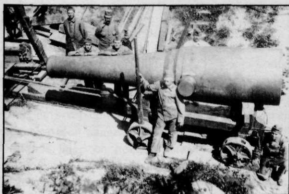
Afb. 5 Een 24 cm ijzer kanon, gebruikt voor de verdediging van de kust en de zeearmen. Dit was het grootste type dat het Nederlandse leger voor de kustverdediging toepaste. Op deze foto, genomen op 6 juli 1917, wordt een 24 cm kanon in het fort De Ruyter van zijn affuit genomen
