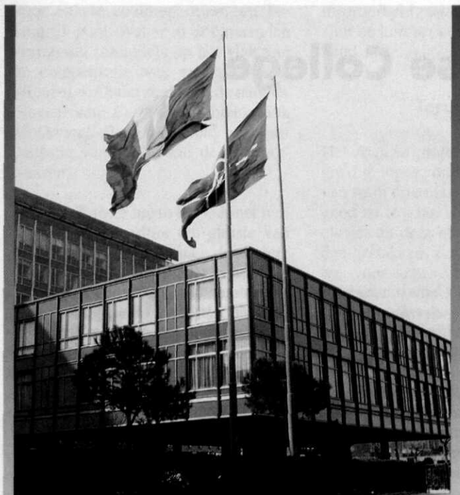
Afb. 1 Het flatgebouw waar het NDC is ondergebracht
