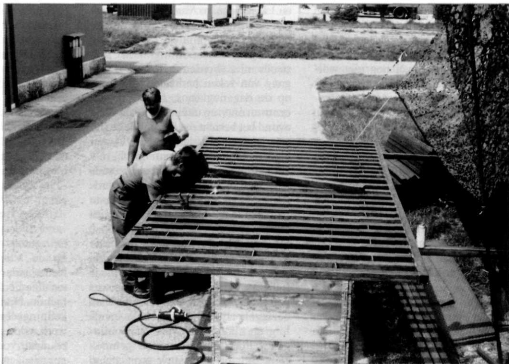
Afb. 1 Roosters worden vervaardigd ter bestrijding van Foreign Object Damage
