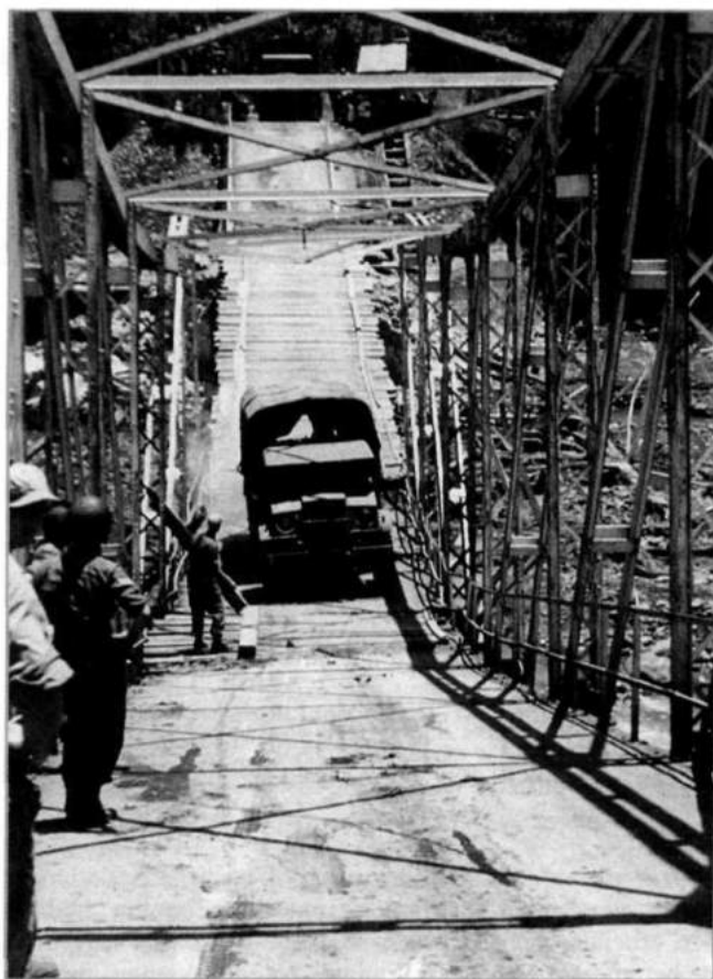
Afb. 4 Een provisorisch herstelde vakwerkbrug bij Wlinggi op Oost-Java
