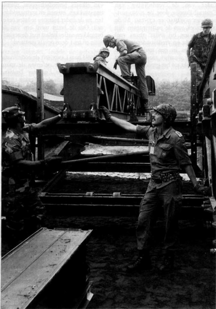
Afb. 2 Het bouwen van een MGB-brug onder Amerikaanse leiding (foto: 101 Gngcvgp)
