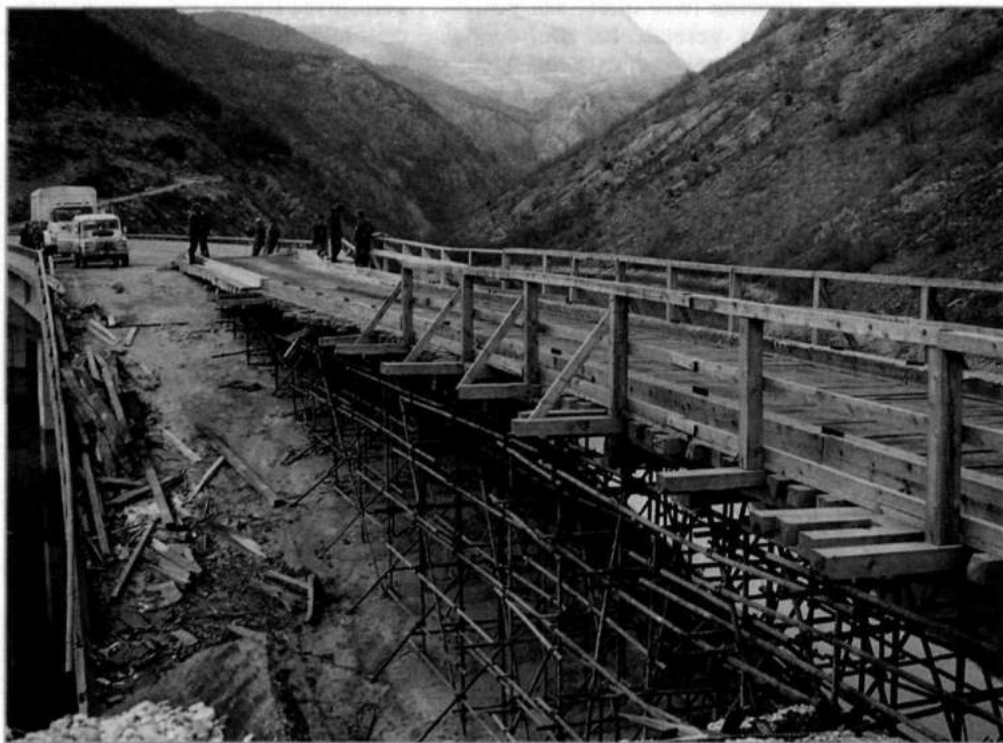
Afb. 4 De 'Bijelina Bridge' (Mostar-route), meerdere keren opgeblazen, gerepareerd door Britse genisten (foto: M.S.H. Bont)
