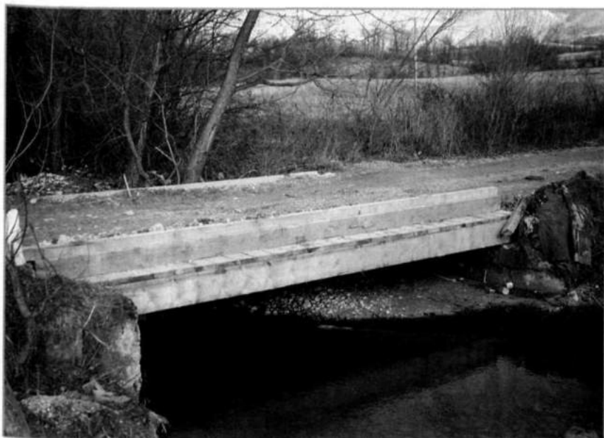
Afb. 2 Mobiliteit: nieuwe houten brug in de route Knesevo-Sisava (foto: A.J. Hogenberg)
