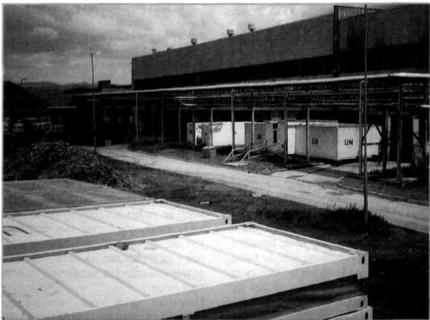
Afb. 1 Sanitaire straat (bestaande uit 21.000 liter watertank, pomphuis, twee sanitair-containers, verbonden door een kleedruimte), Potocari (foto: A.B.G.J. Linsen)
