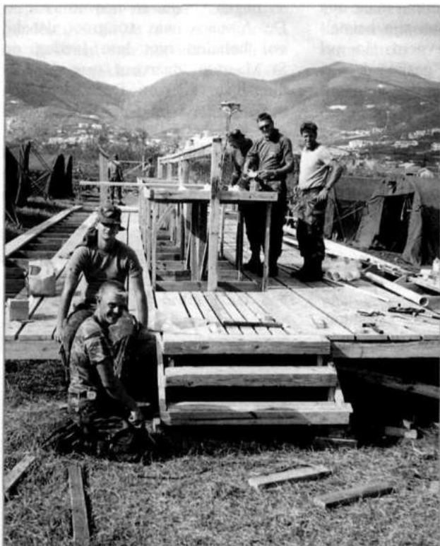
Afb. 6 Het bouwen van een wasplaats in een opvangkamp bestaande uit boogtenten (foto: E.R. Sinninghe)
