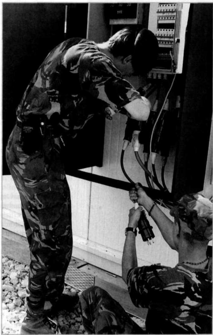
Afb. 2 Genie-elektriciens verzorgen de nodige aansluitingen (foto: MC ILMO/SMG/KL)
