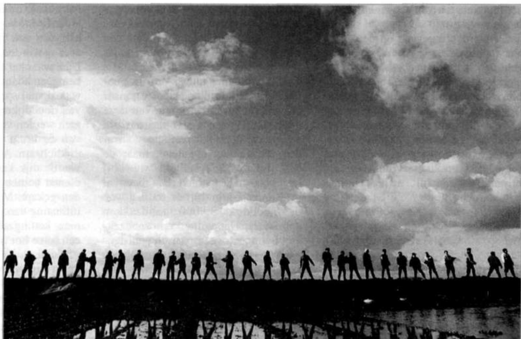
Afb. 1 Zandzakken gaan van hand tot hand bij de aanleg van een nooddijk (Arcen, Limburg)
