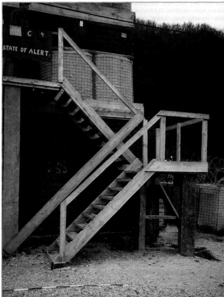
Afb. 3 Trap aan de achterzijde van de observatiepost (foto: A.B.G.J. Linsen)
