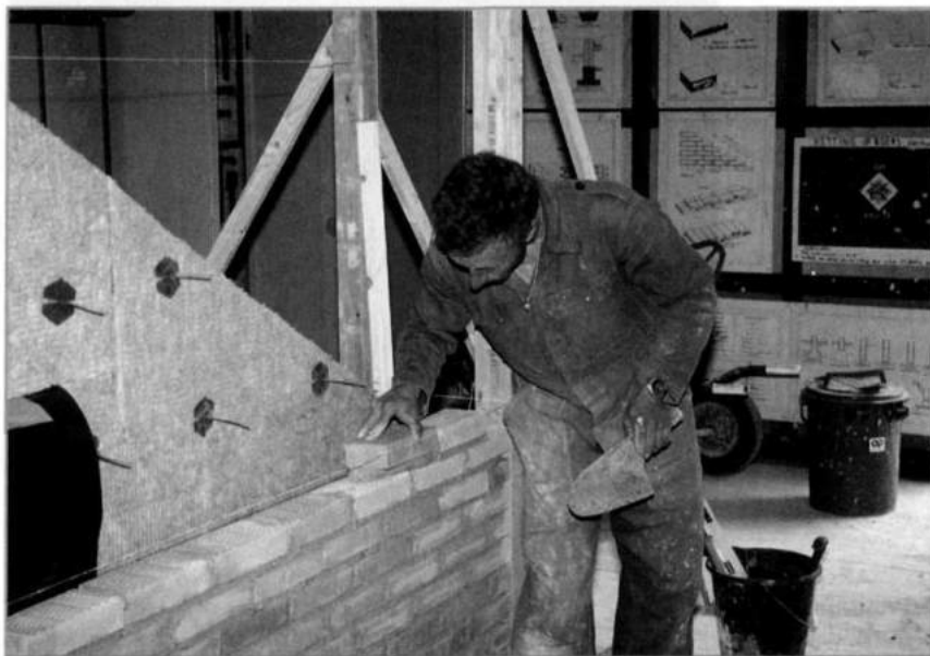
Afb. 3 Opleiding metselen (foto: GOC)
