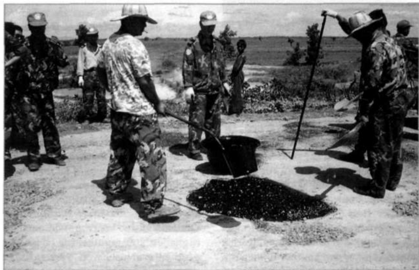
Afb. 5 Chinese genisten plegen wegherstel met koud asfalt onder leiding van de Nederlandse majoor Joha (foto: H.J.J.M. Joha)
