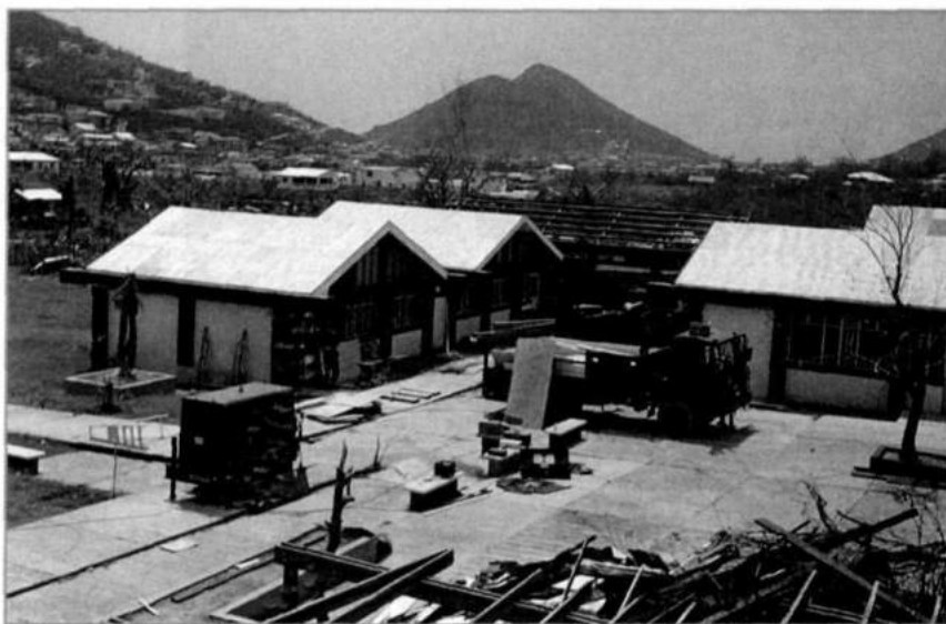
Afb. 7 Nieuwe daken op een school... (foto: E.R. Sinninghe)
