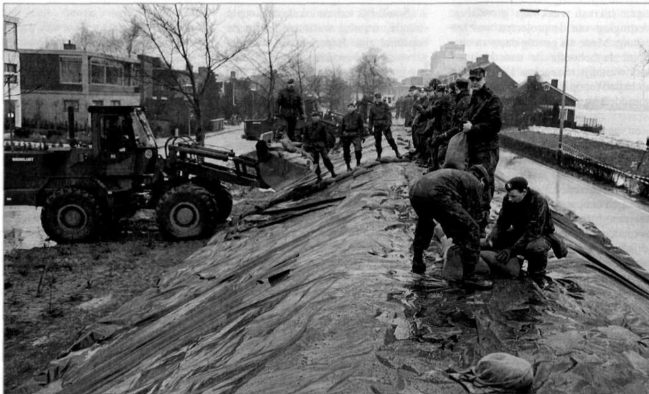
Afb. 2 Het aanleggen van de nooddijk bij Kampen (foto: F. Schinkel)
