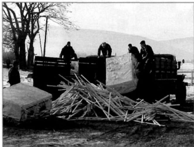
Afb. 5 Brugslag bij Rakovina: improvisatie en doorzet- tingsvermogen verbindt beide oevers van de Beli Drim
