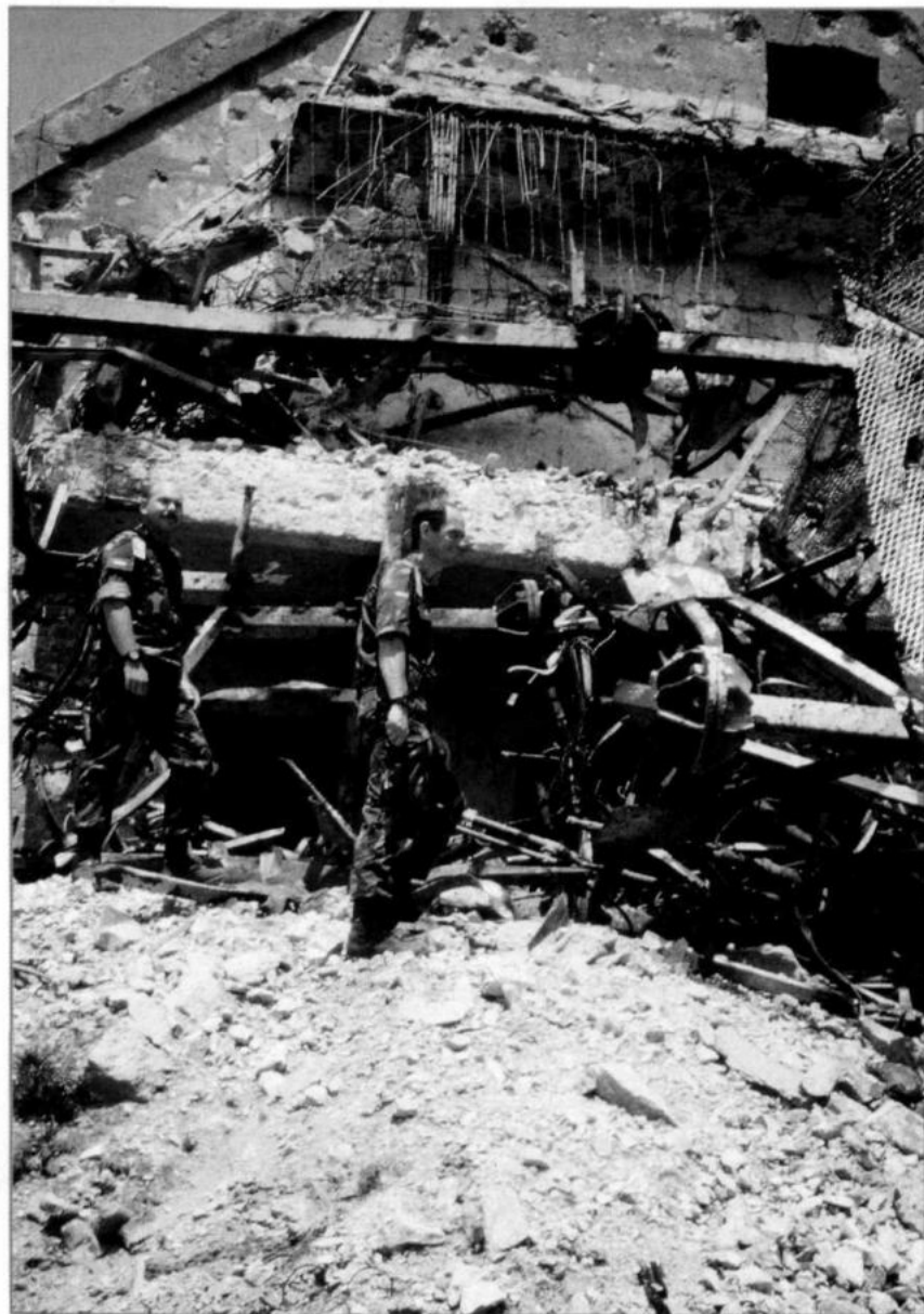
Afb. 13 Door kruisraketten van de NAVO vernielde communicatiebunker
