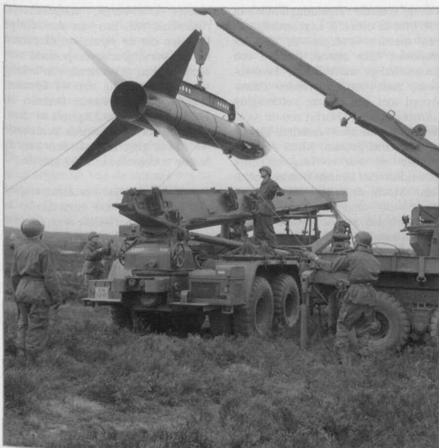
Het laden van een Honest John raket MGR-1A op de lanceerinrichting moest met grote precisie gebeuren. Opleiding nabij Legerplaats 't Harde, 1960 (Bron: IMG/KL)
