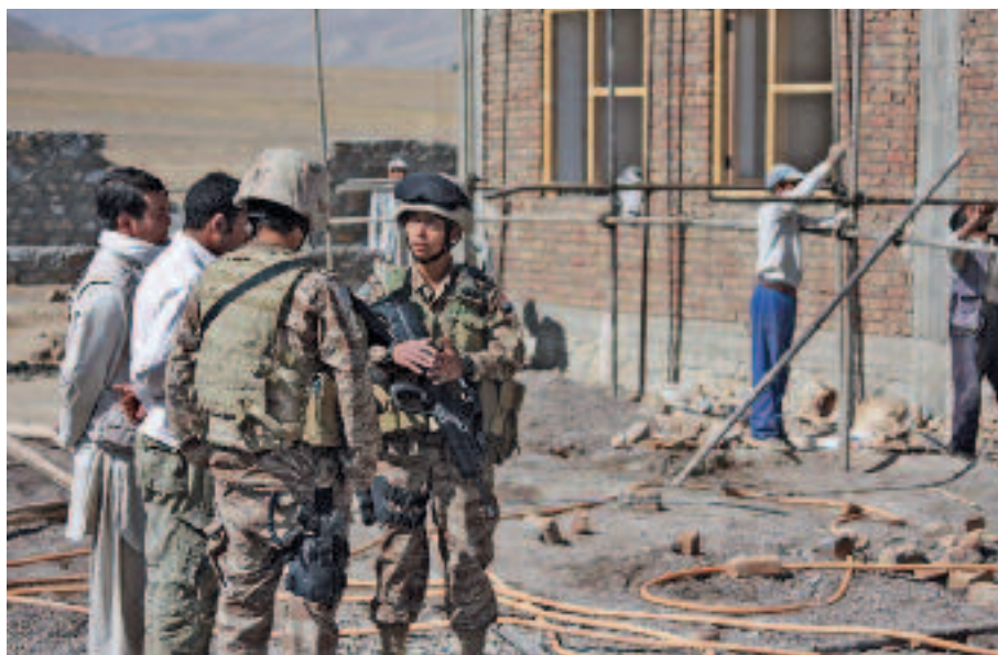
Overleg met de lokale contractanten op de bouwplaats van het Bamyān 'Regional Health Training Center'. Afghanistan, 2008
