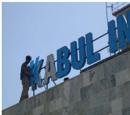
Renovatie van de passagiersterminal. Kabul International Airport, 2007
