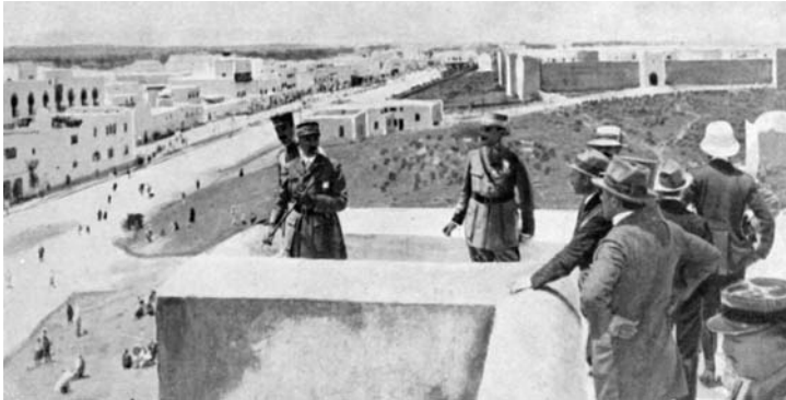
Generaal Lyautey inspecteert bouwwerkzaamheden in Rabat, 1917
