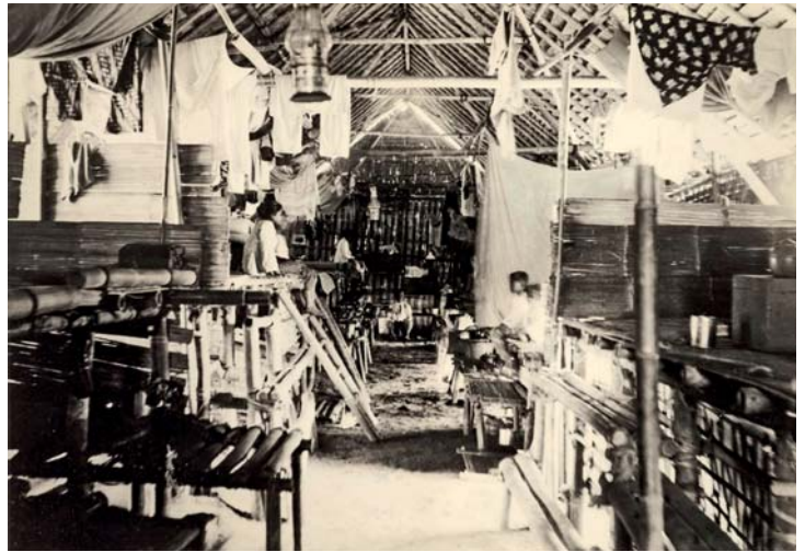
Slaapzaal, compleet opgebouwd uit bamboe, in een bivak ergens in Atjeh, circa 1890
