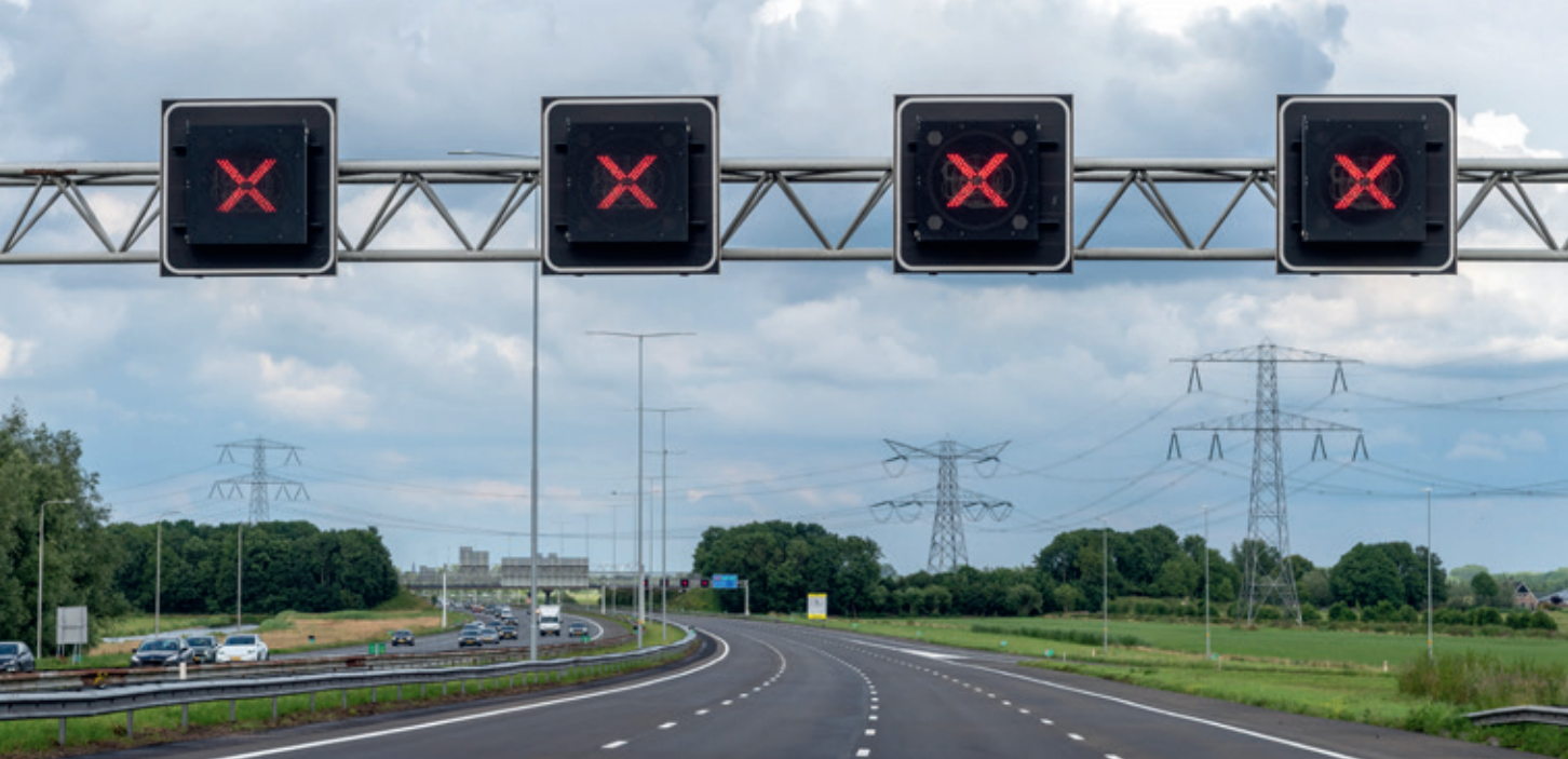
Typische voorbeelden van vitale infrastructuur zijn het wegennet en het elektriciteitsnetwerk
