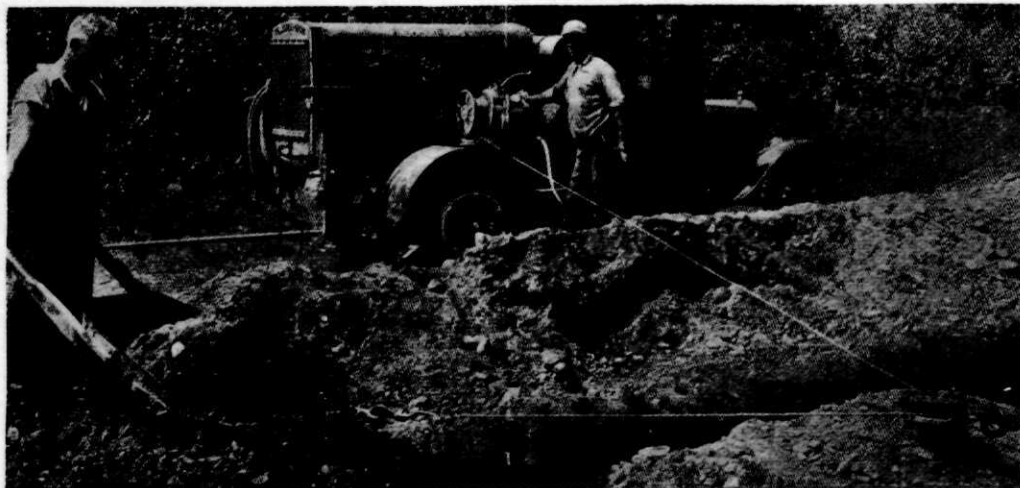
Afb. 1. Pneumatische lier, waarmede een schrapbak wordt bewogen.
