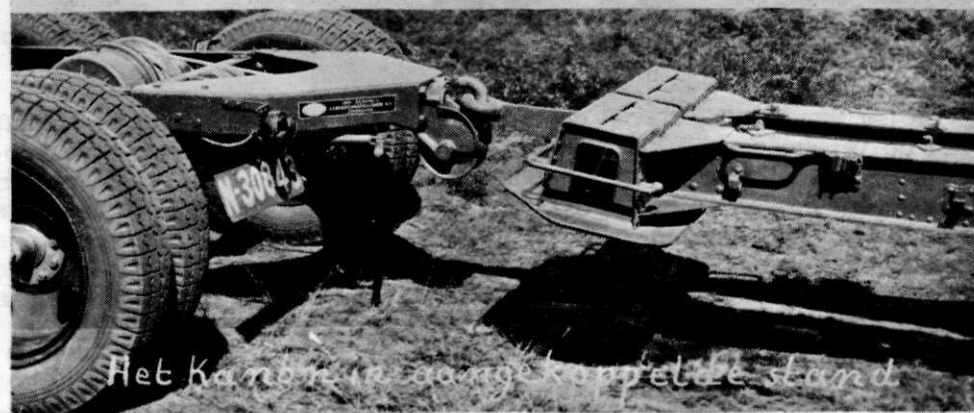
Afb. 5. De liermanoeuvre en automatische aankoppeling.
