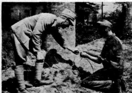
Afb. 1. Aanbrengen van een lading in boorgaten.
