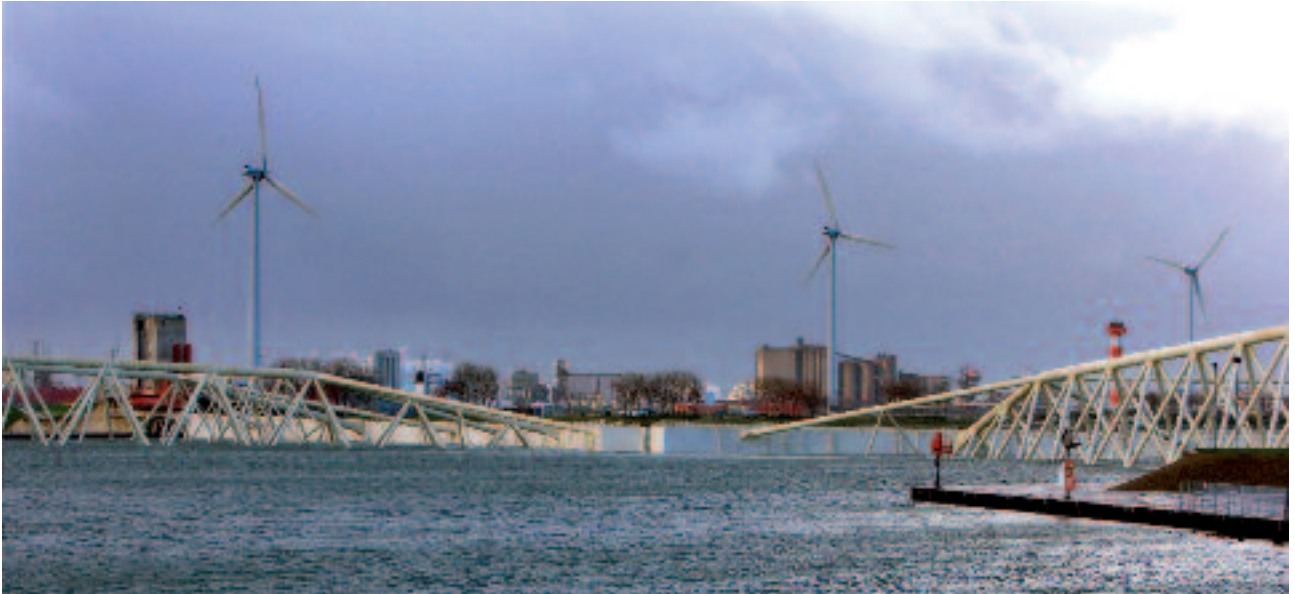
De Maeslantkering in de Nieuwe Waterweg. De beveiliging van procescontrolesystemen, onder meer toegepast in waterbouwkundige werken die de continuïteit aan het functioneren van Nederland garanderen, verdient extra aandacht
