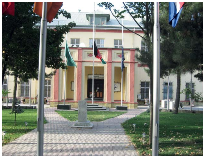
Het Yellow Building, onderdeel van het ISAF-hoofdkwartier in Kabul
